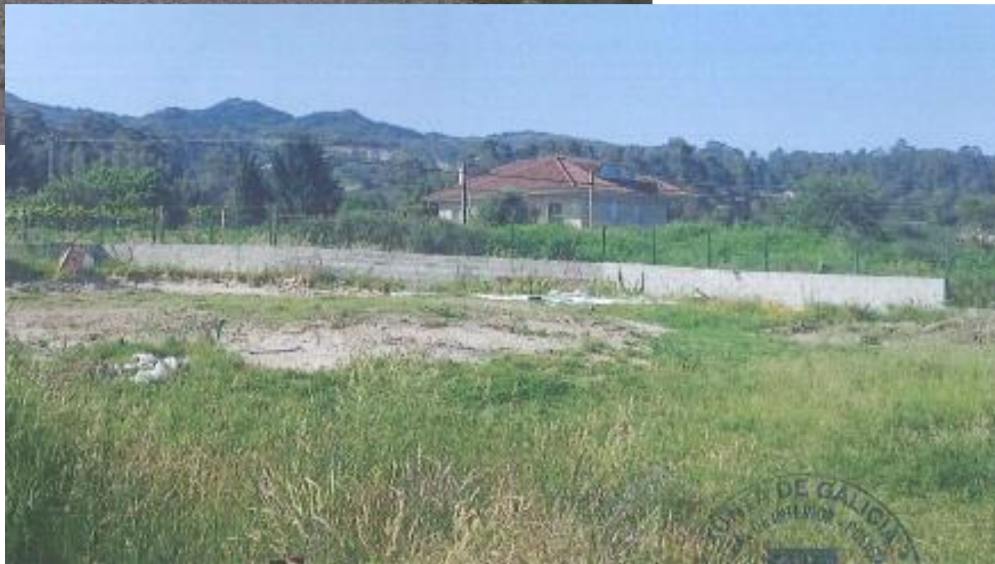
despois da demolição
