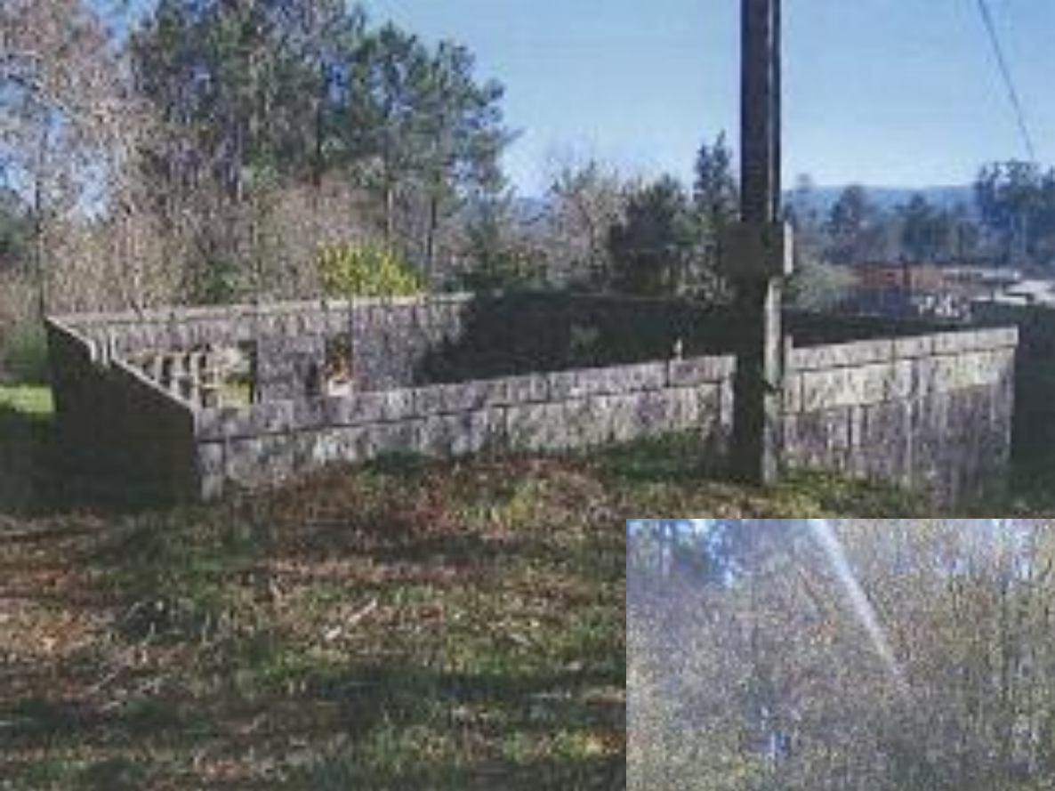
antes da demolición
