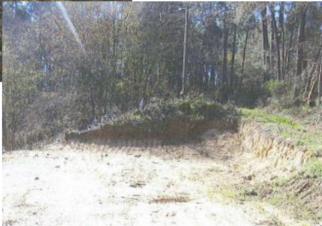
despois da demolición
