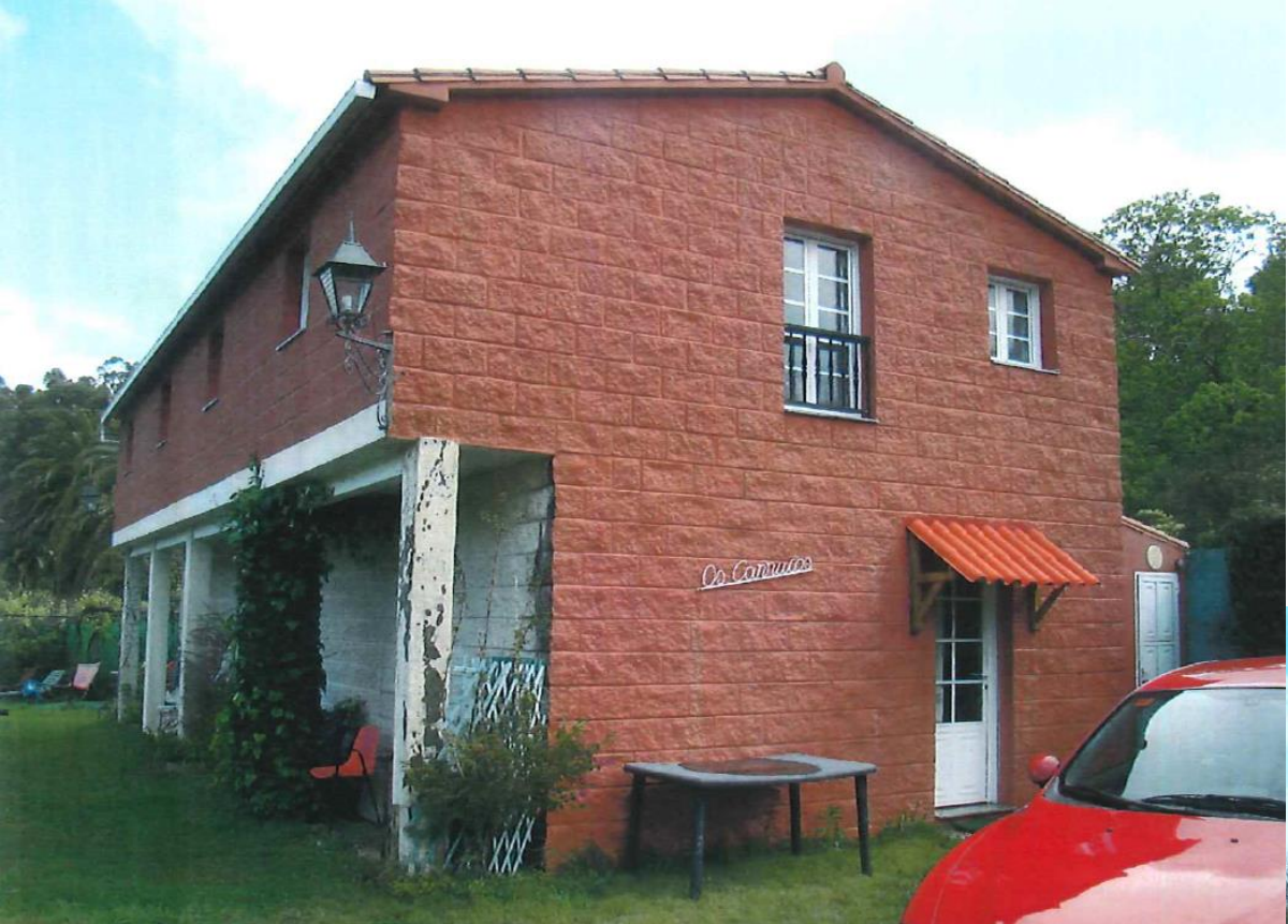
antes da demolición
