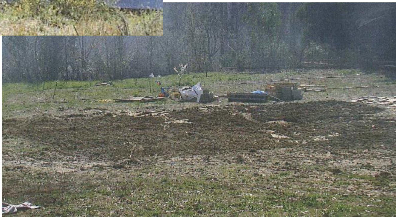
despois da demolición
