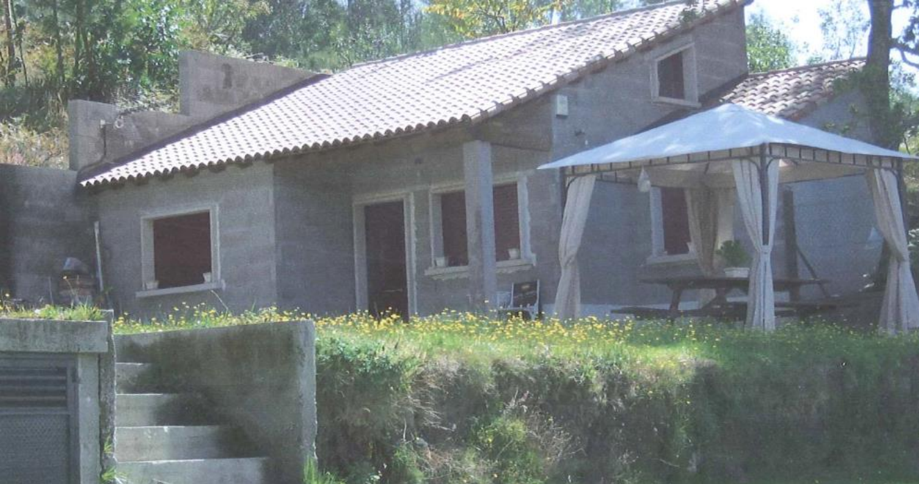
antes da demolición
