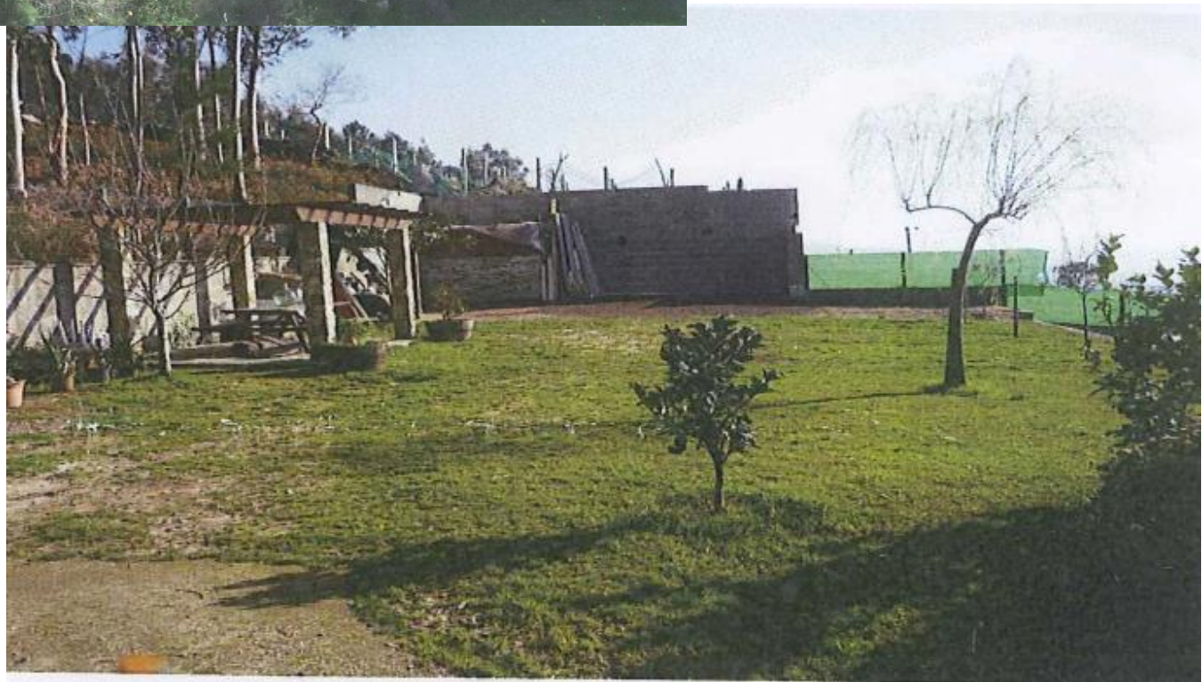
despois da demolición
