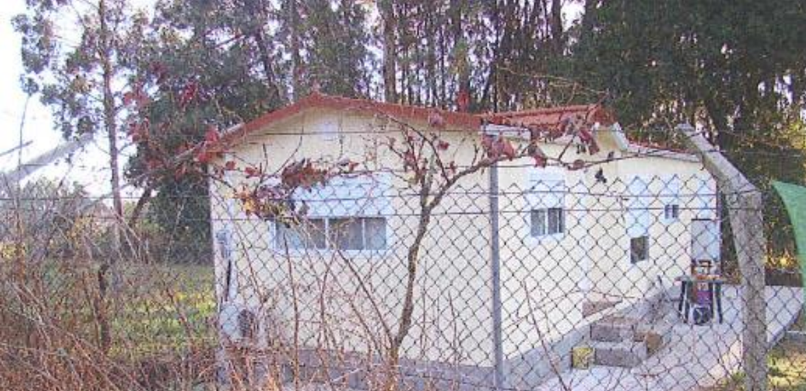
antes da demolición
