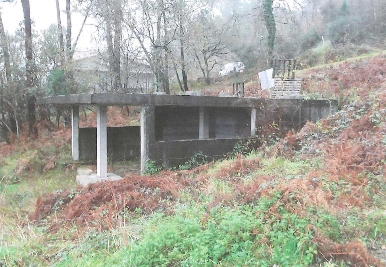
antes da demolición
