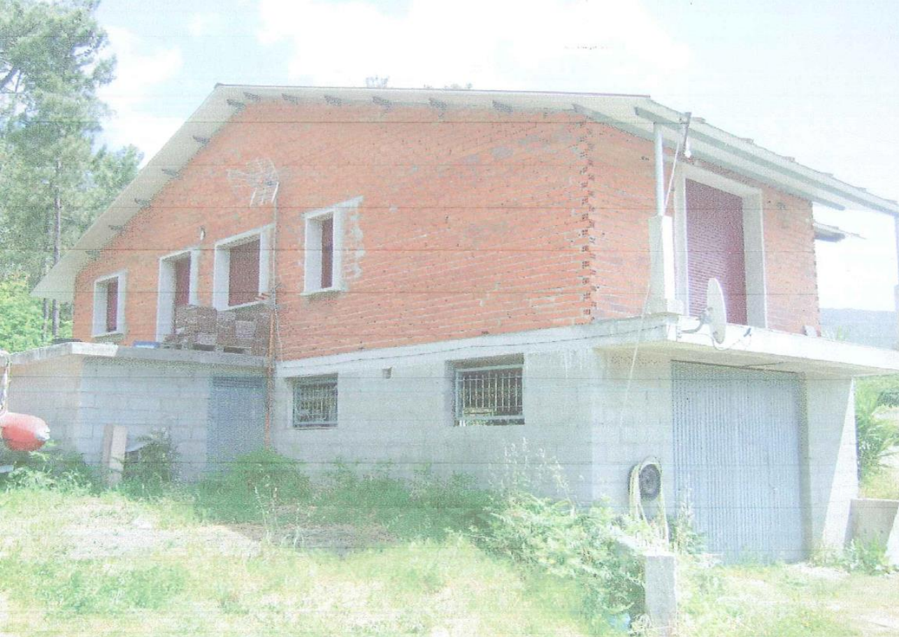
antes da demolición
