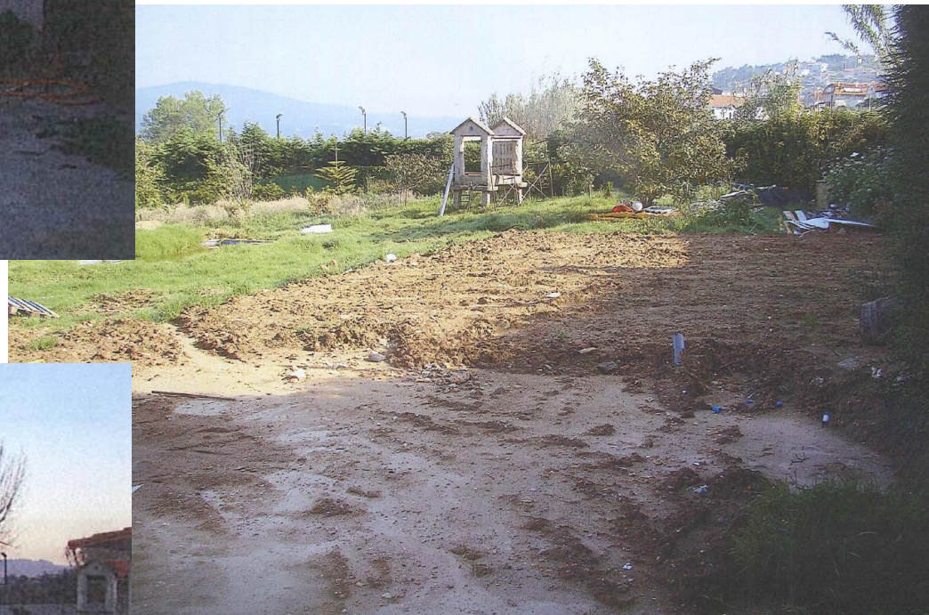
despois da demolición
