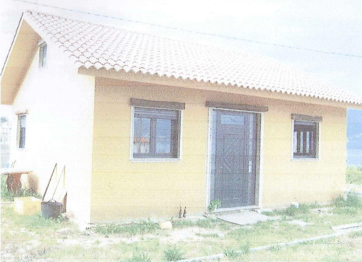
antes da demolición
