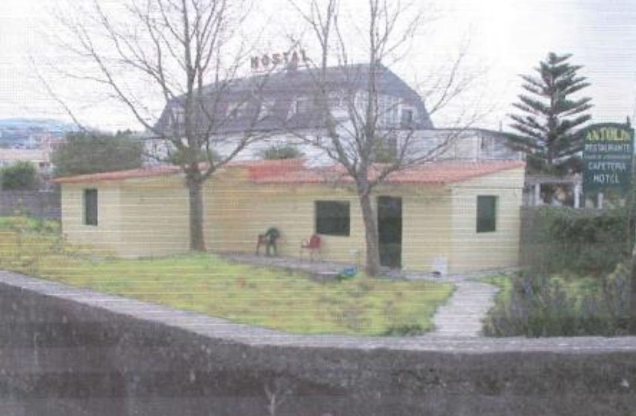
antes da demolición
