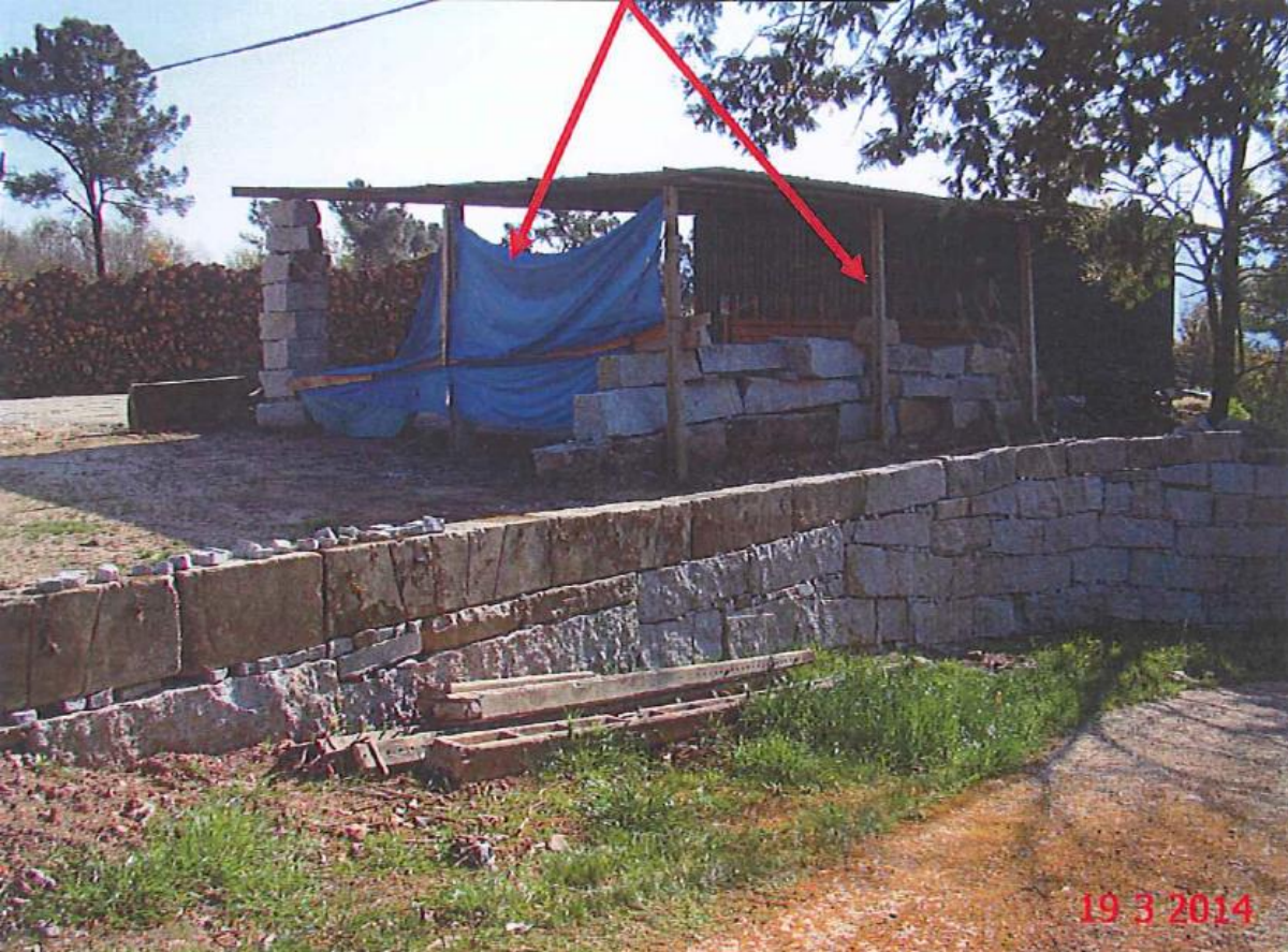
antes da demolición
