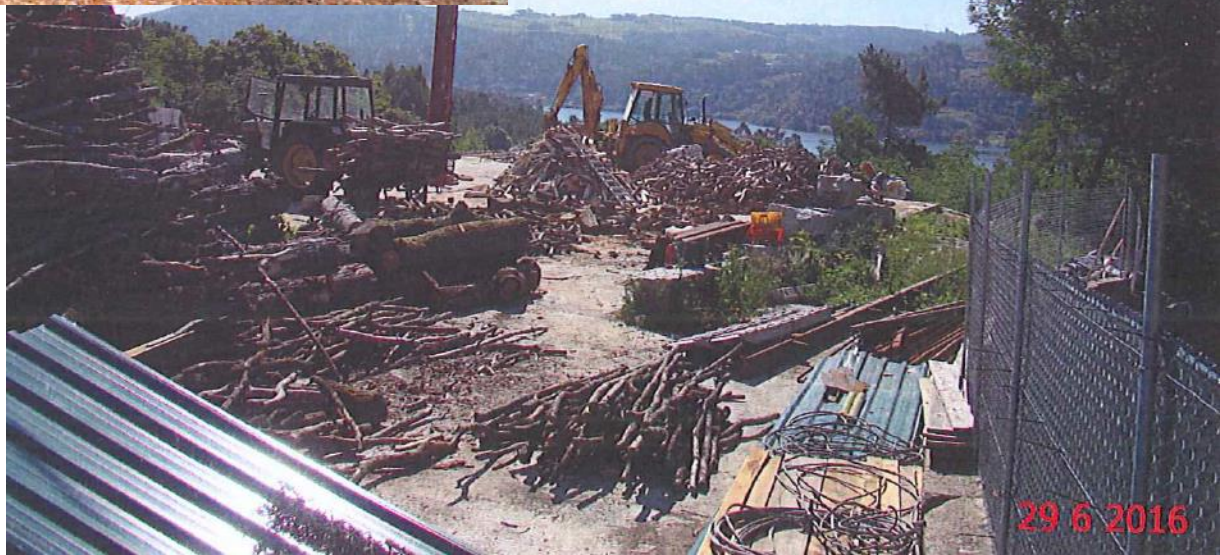
despois da demolición
