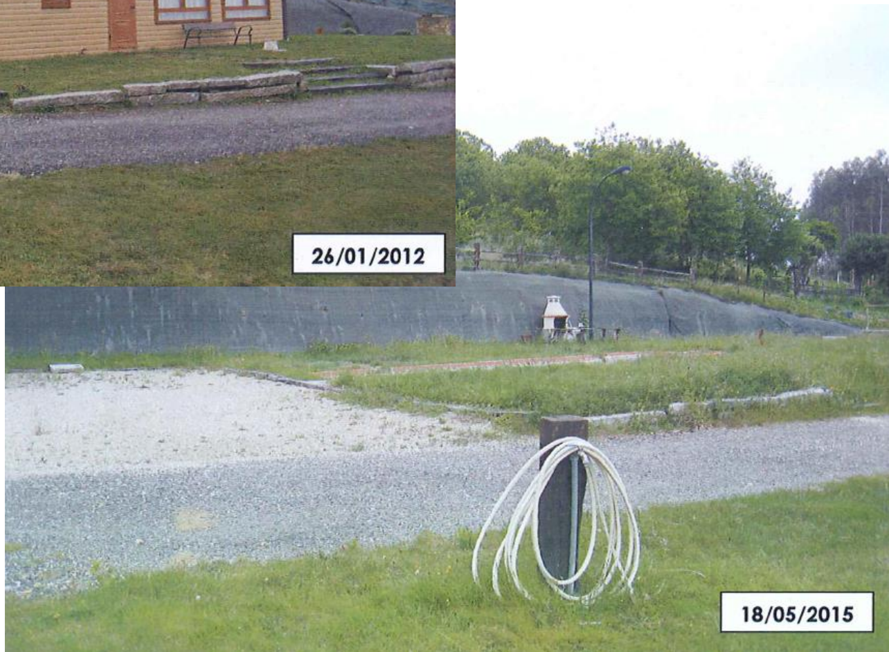
despois da demolición
