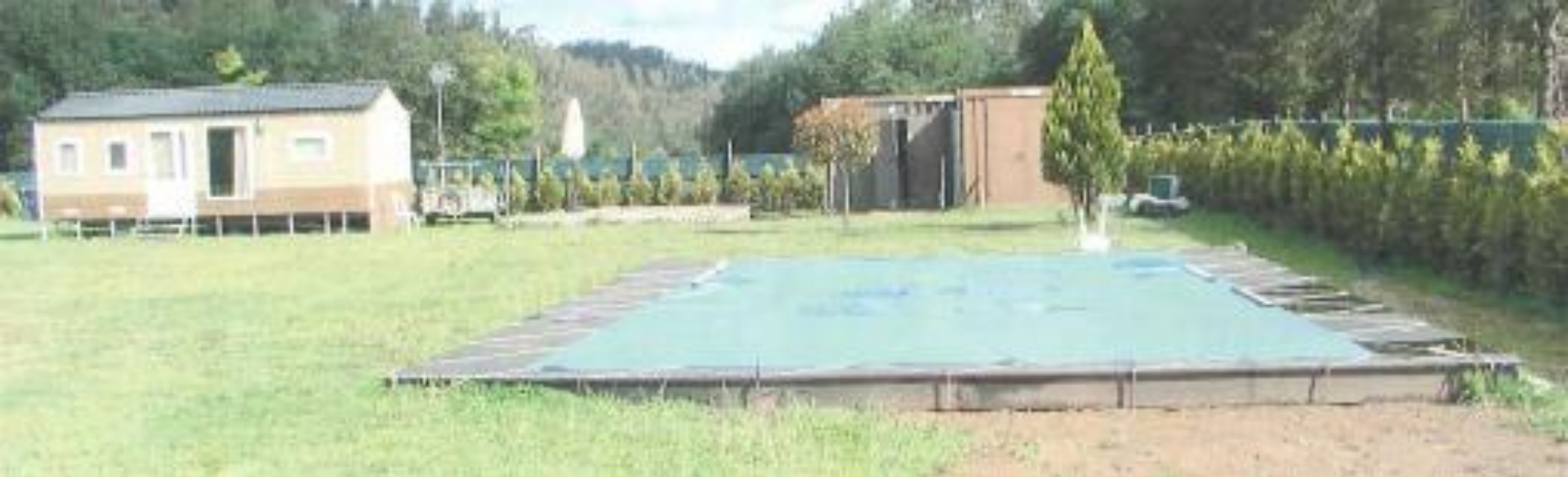
antes da demolição
