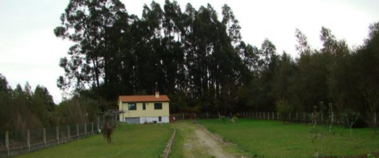
antes da demolición
