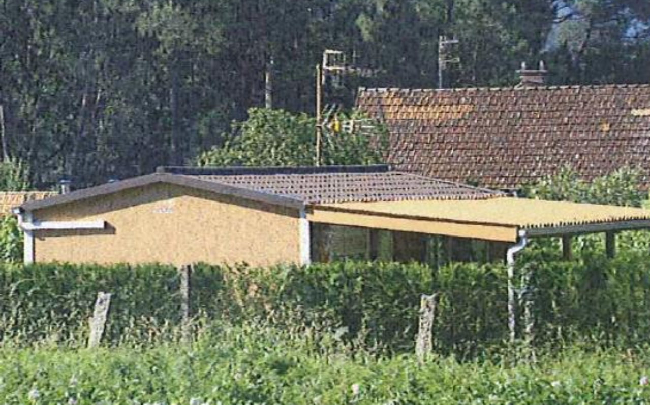
antes da demolición
