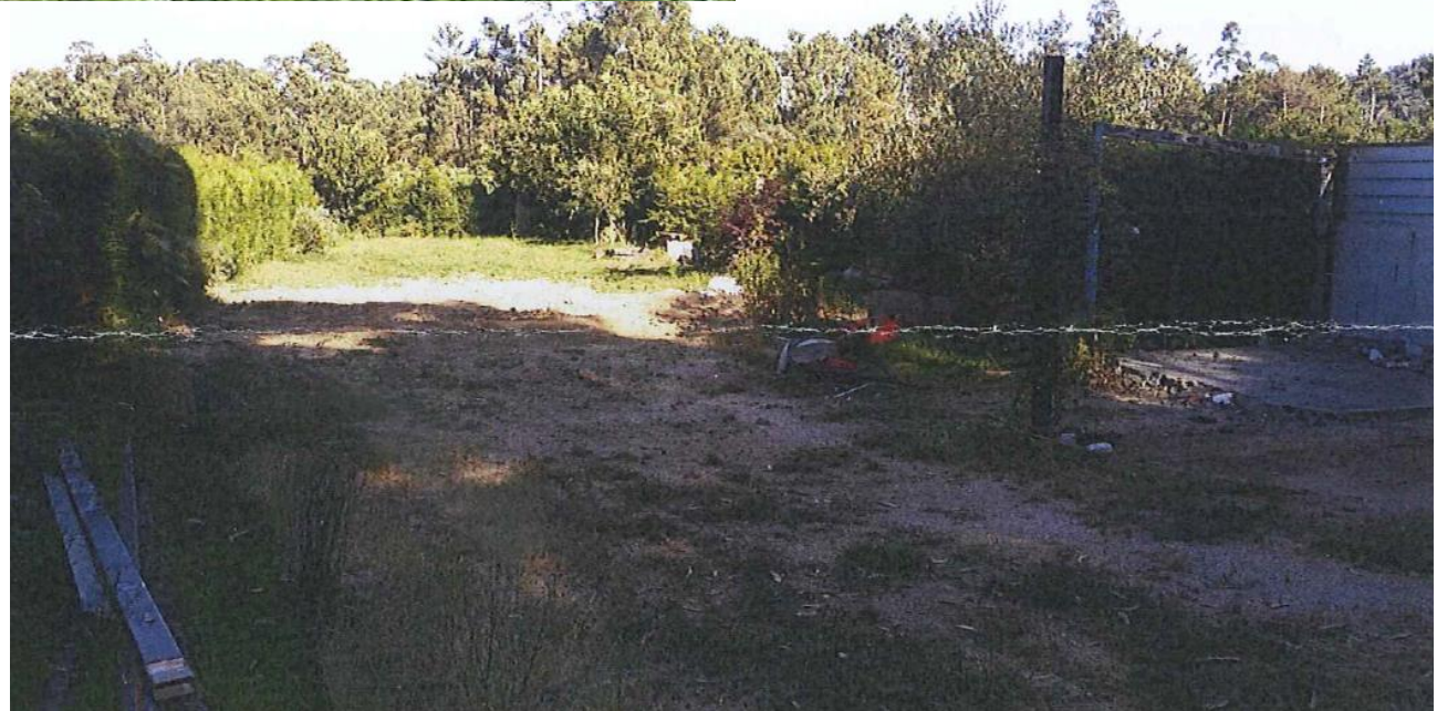
despois da demolición
