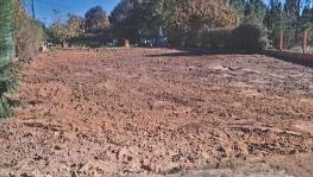
despois da demolición
