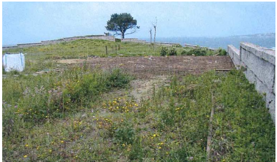
Despois da demolición
