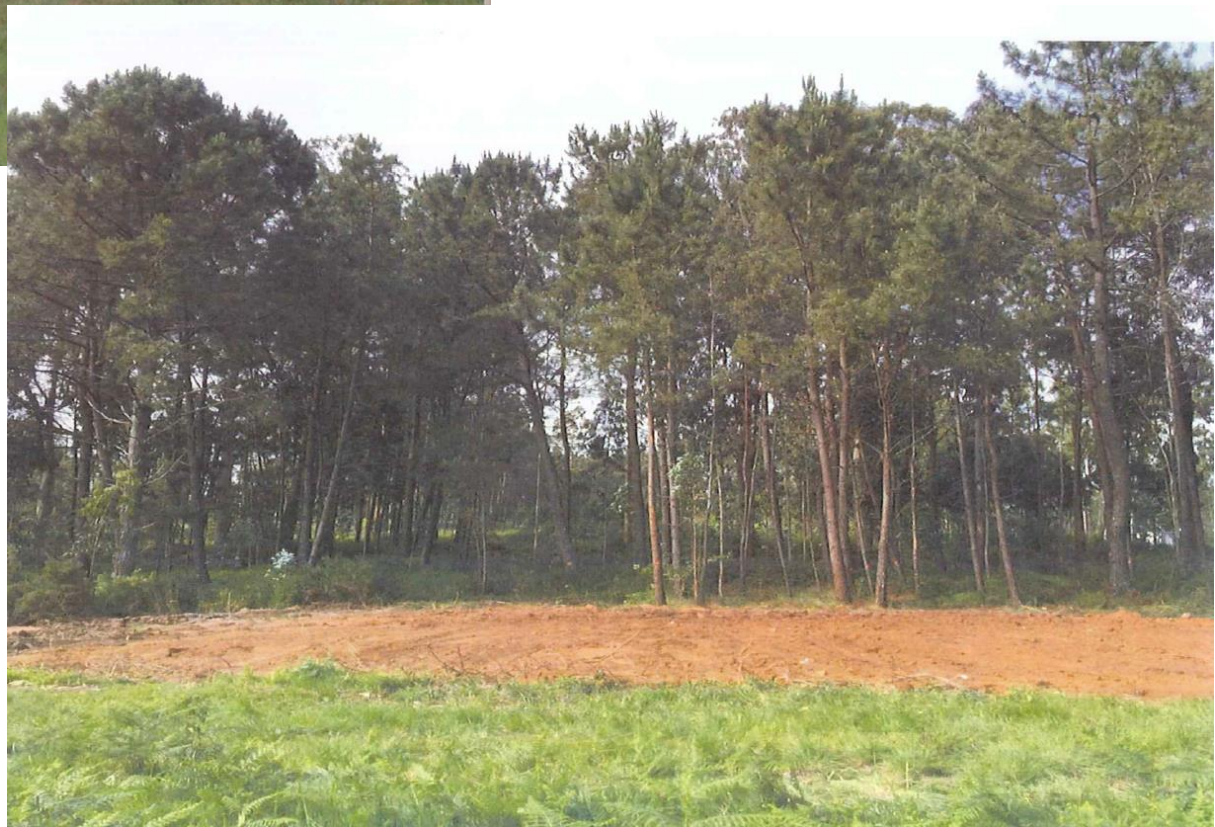
despois da demolición
