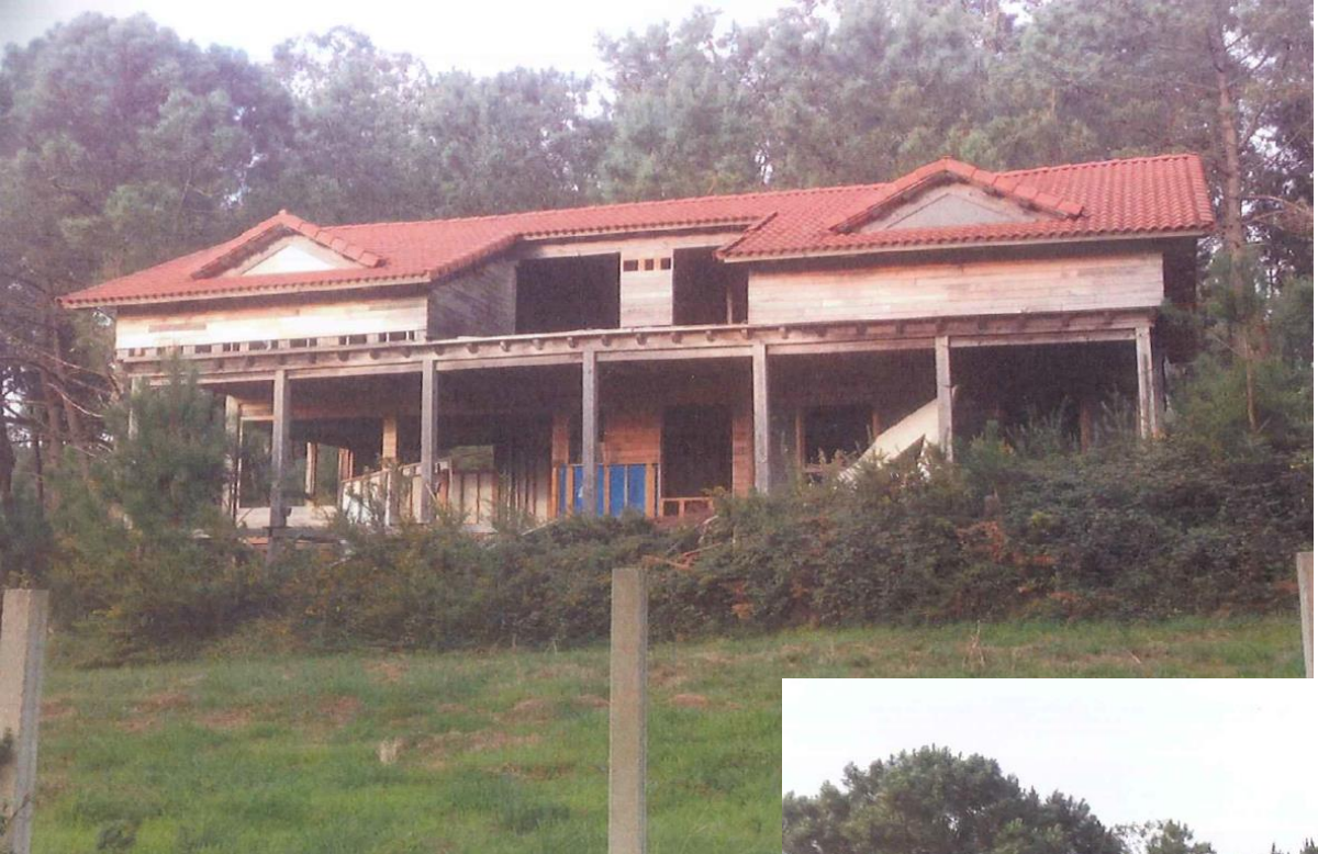
antes da demolición
