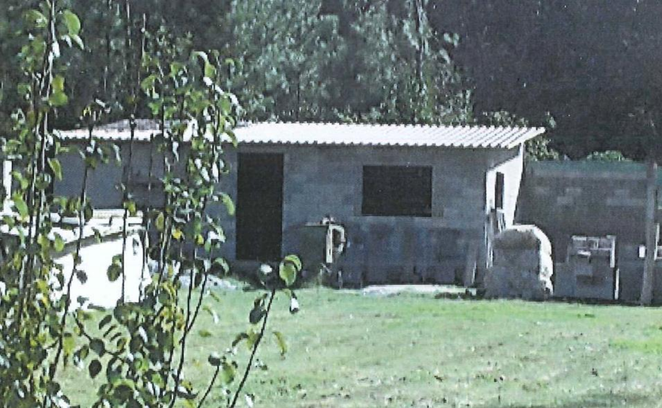
antes da demolición
