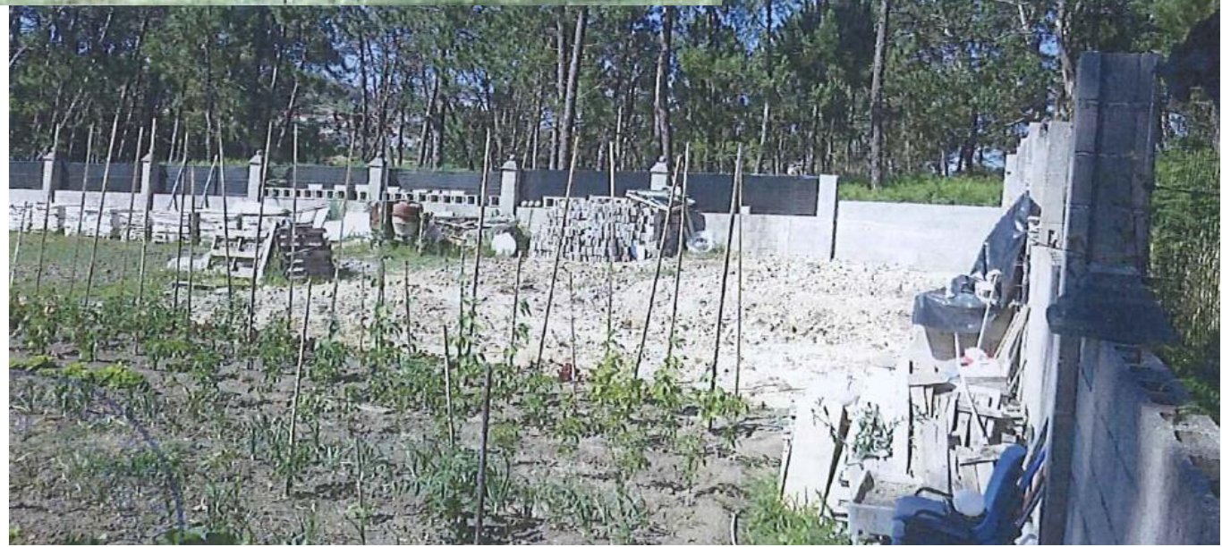
despois da demolición
