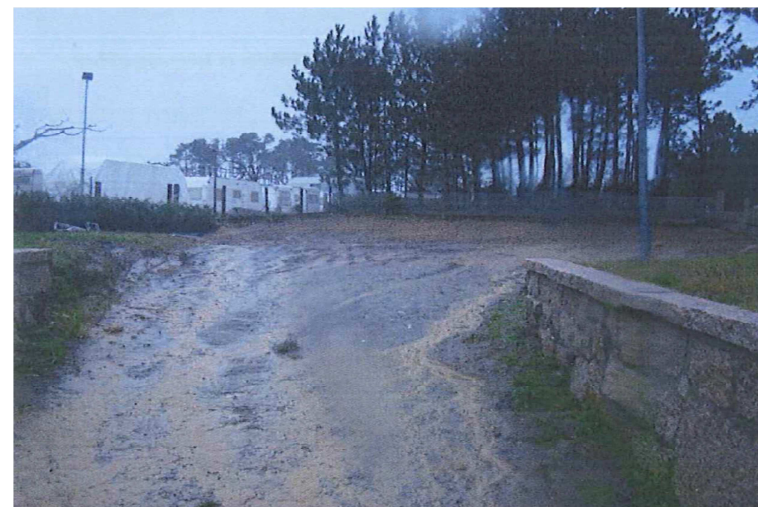
Despois da demolición
