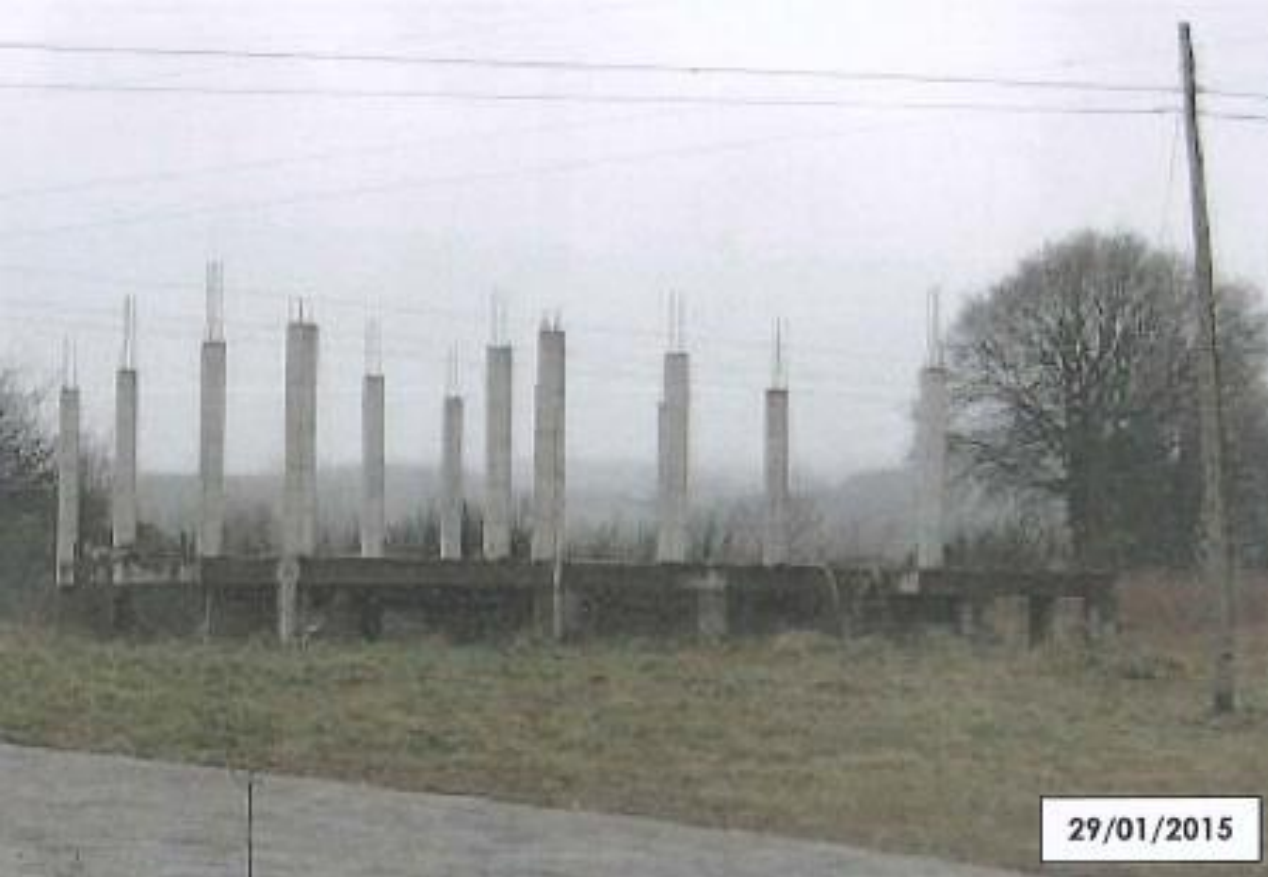
antes da demolición
