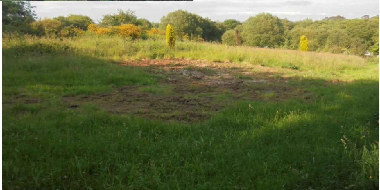
despois da demolición
