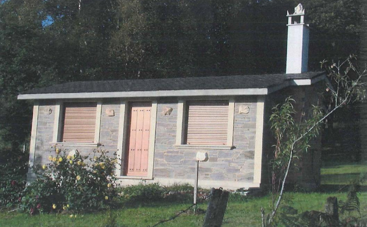
antes da demolición
