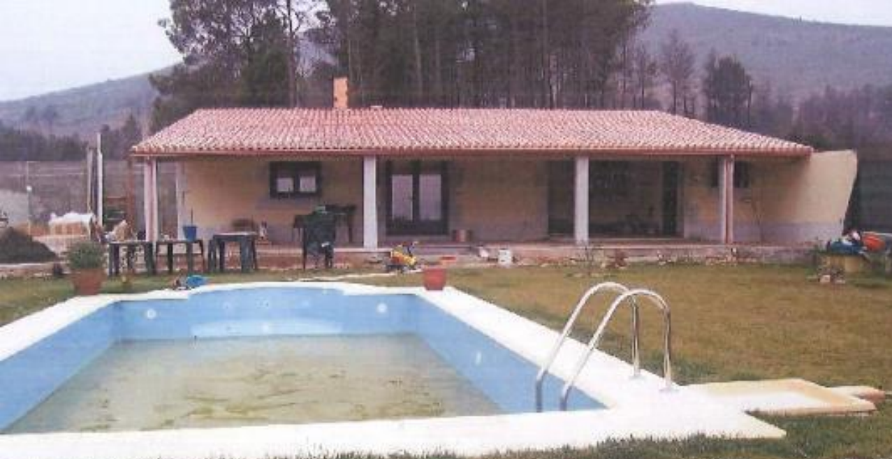
antes da demolición
