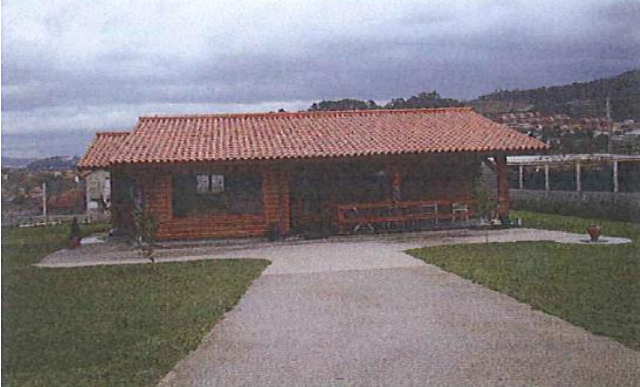
antes da demolición
