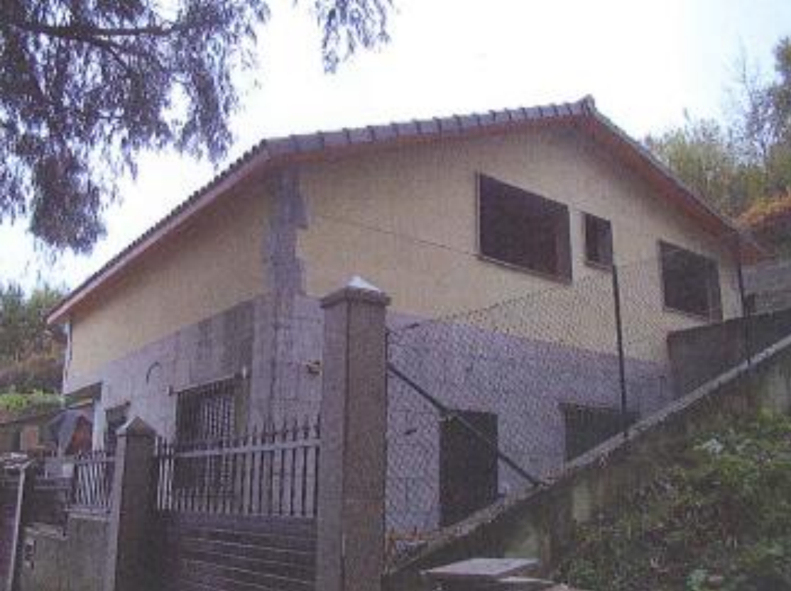
antes da demolición
