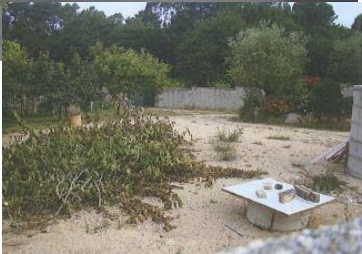
despois da demolición
