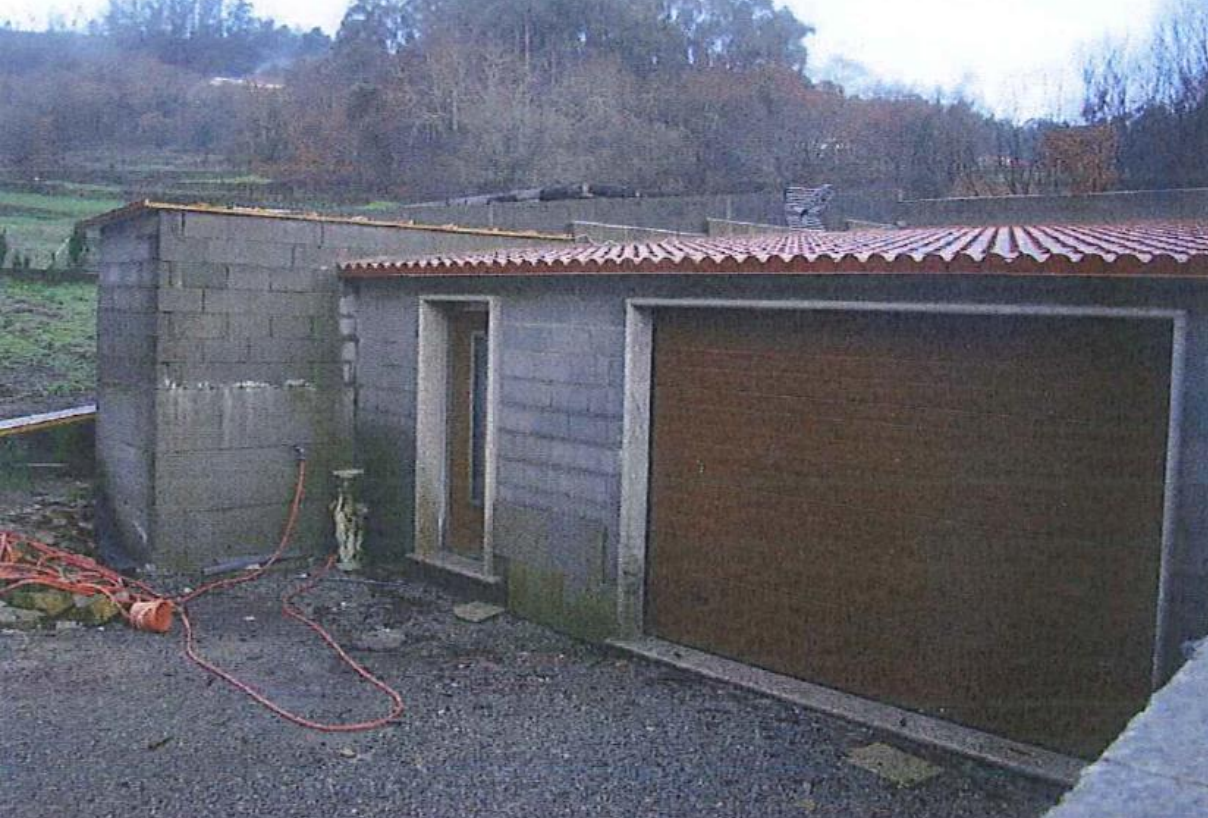
antes da demolición
