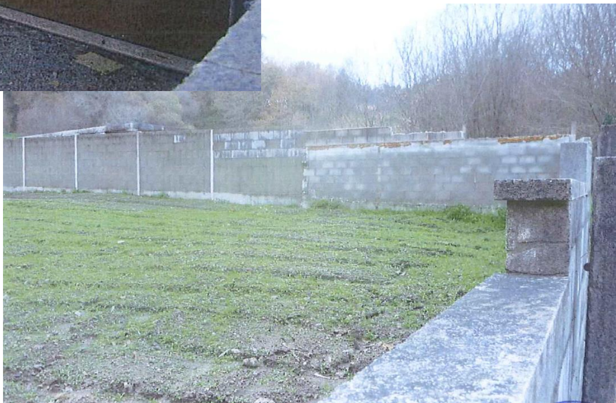
despois da demolición
