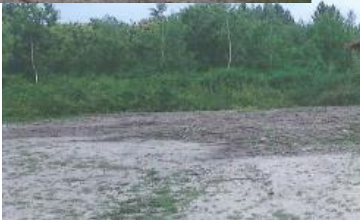
despois da demolición
