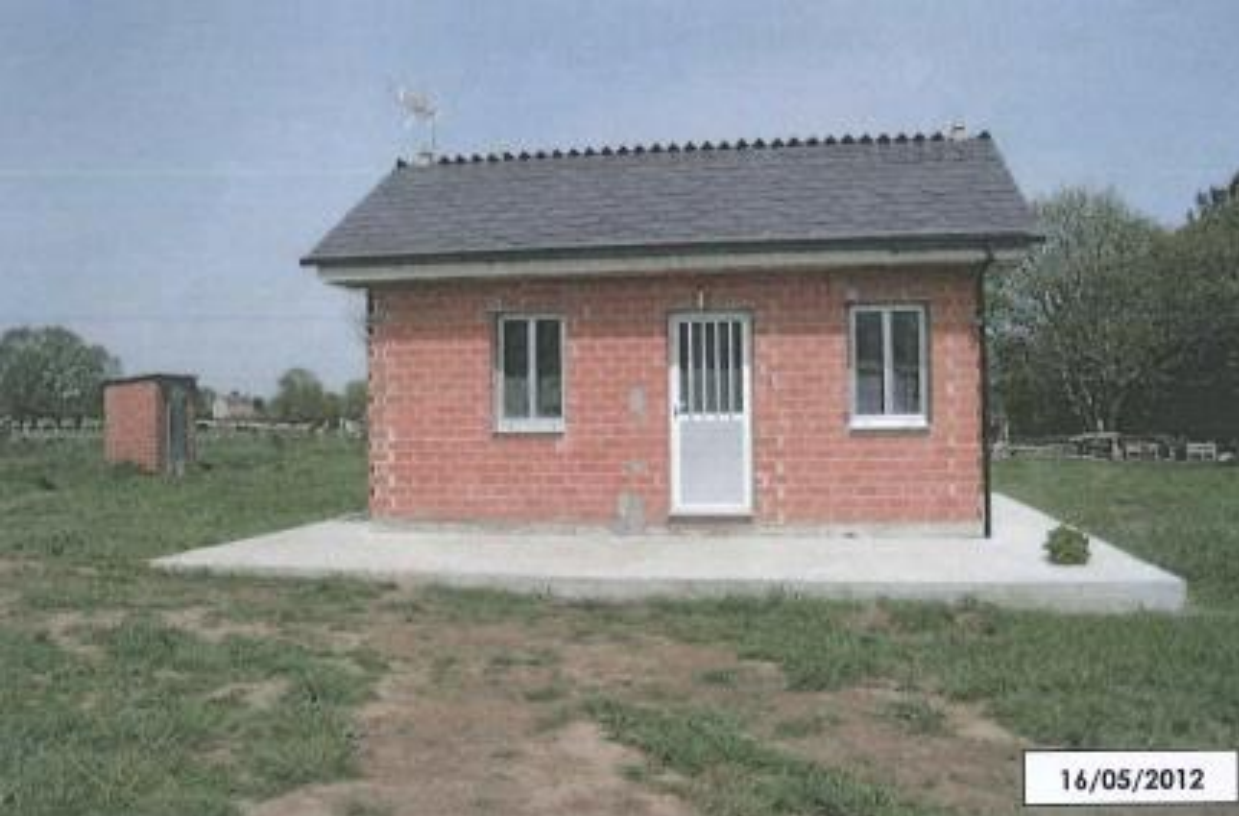
antes da demolición
