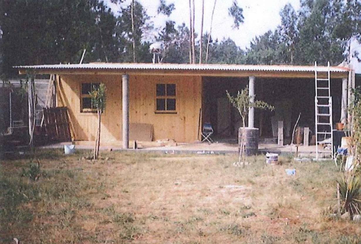
antes da demolición
