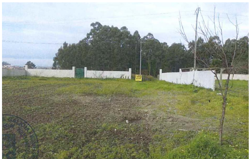
Despois da demolición
