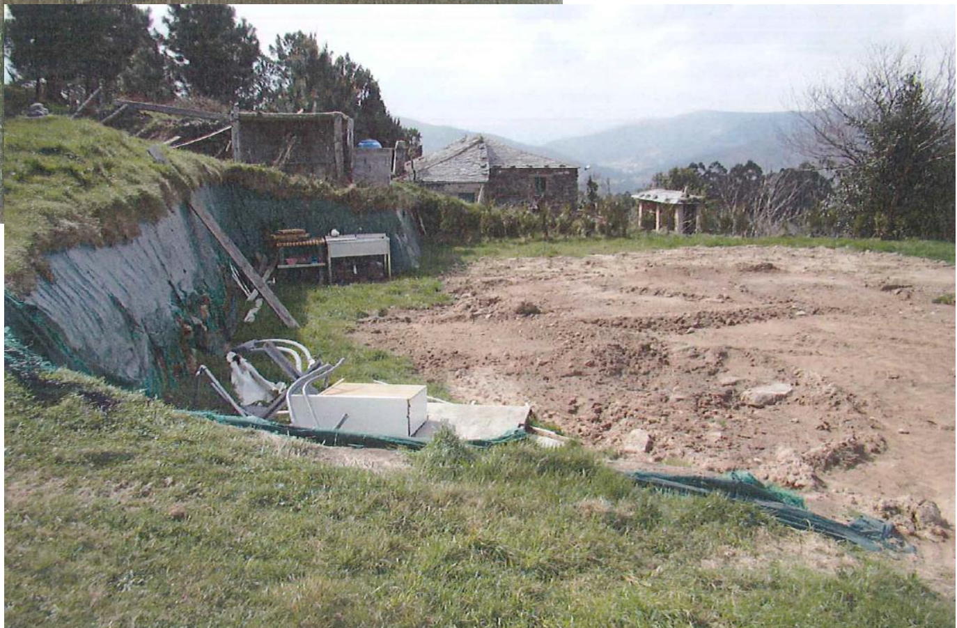
despois da demolición
