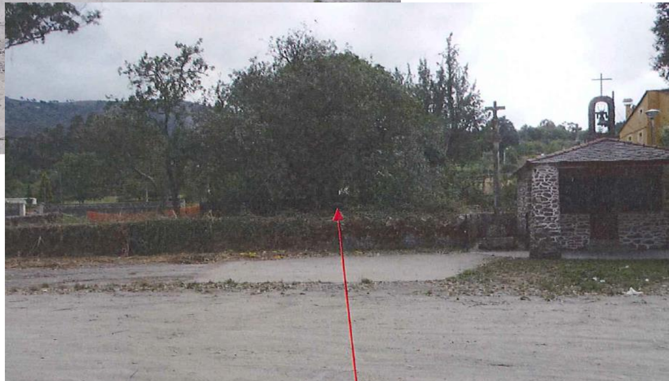
despois da demolición
