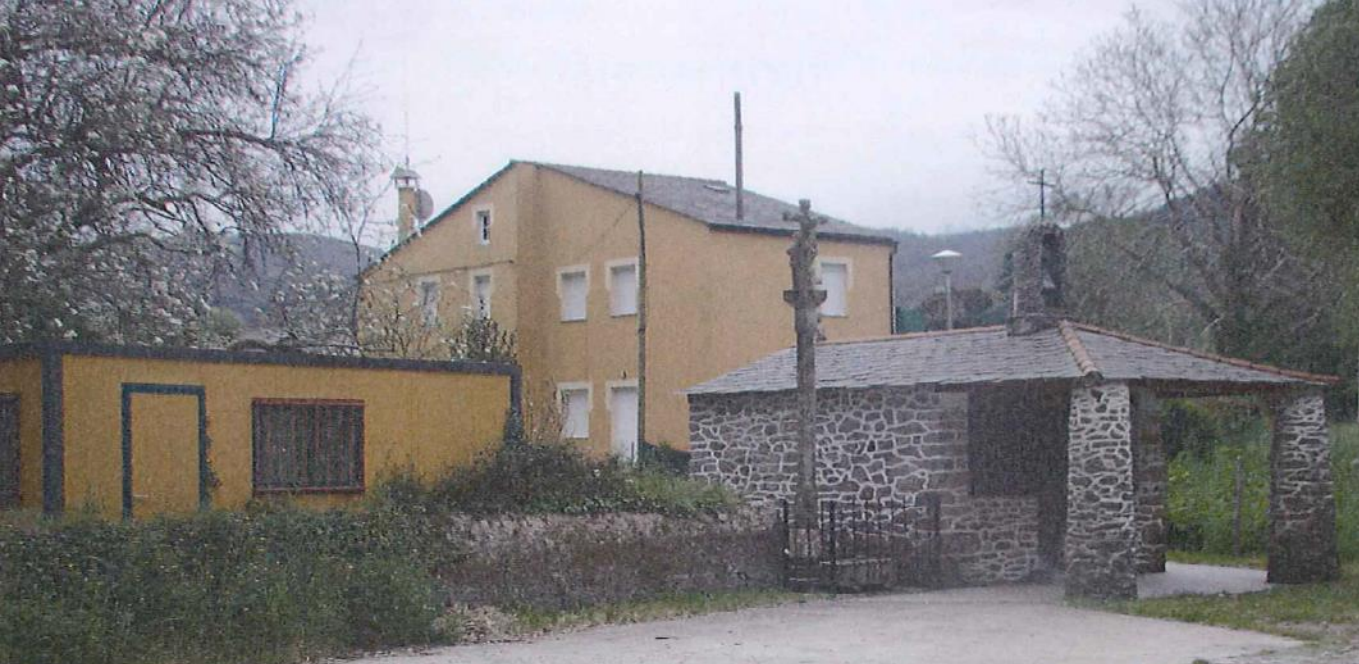
antes da demolición
