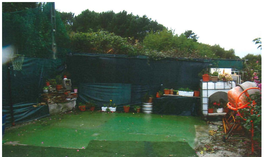
Despois da demolición
