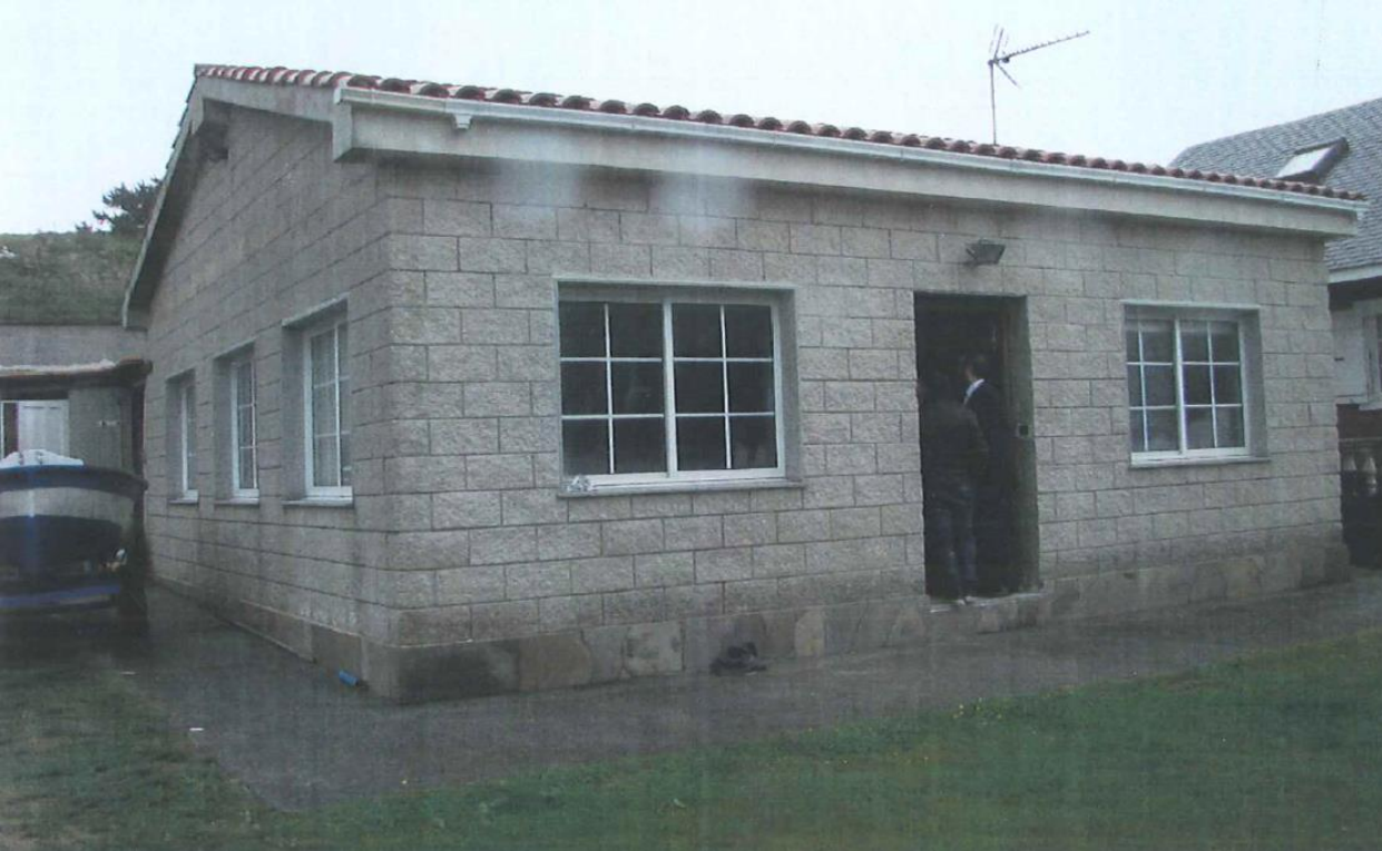
antes da demolición
