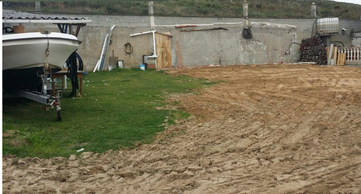
despois da demolición
