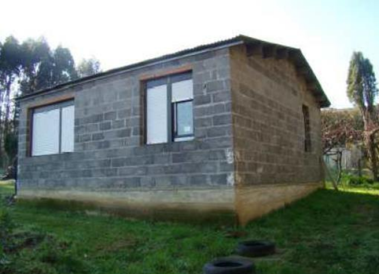
antes da demolición
