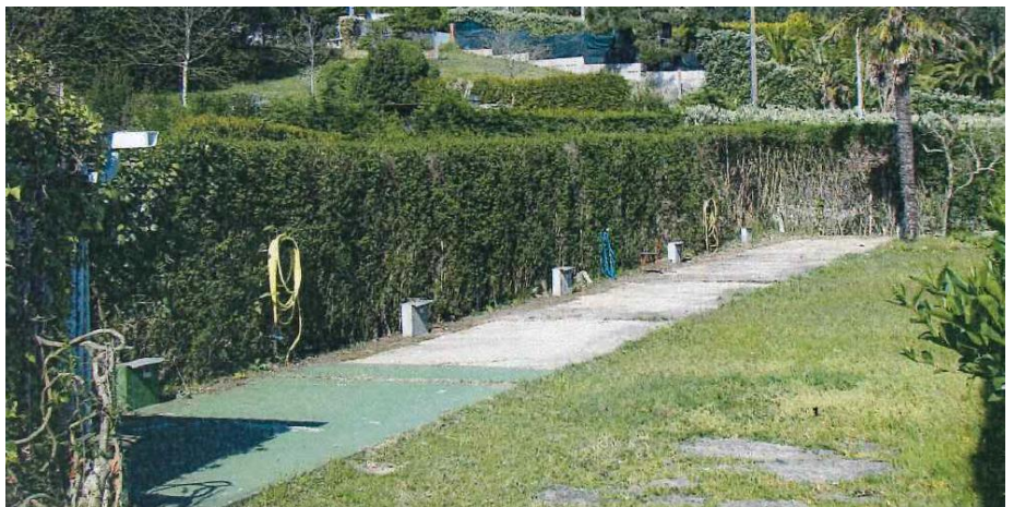
Despois da demolición
