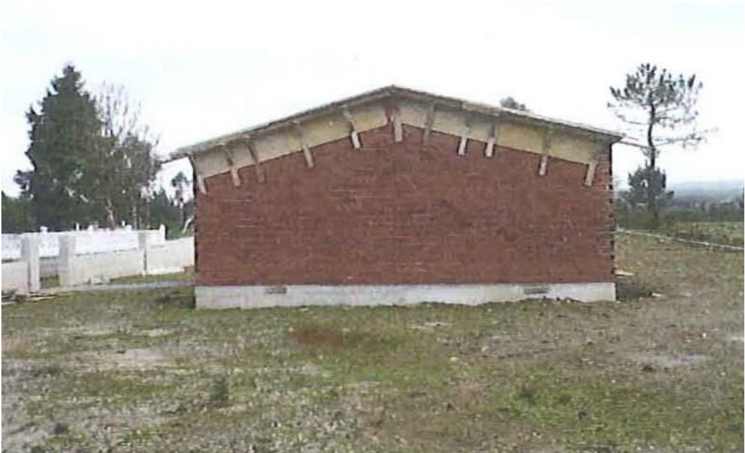
antes da demolición
