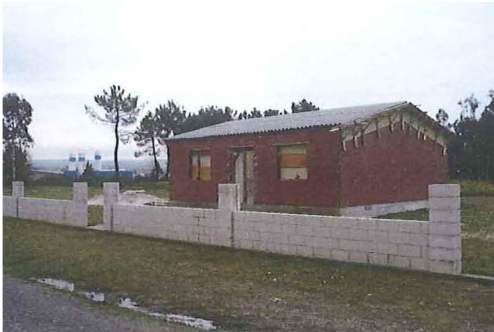
antes da demolición
