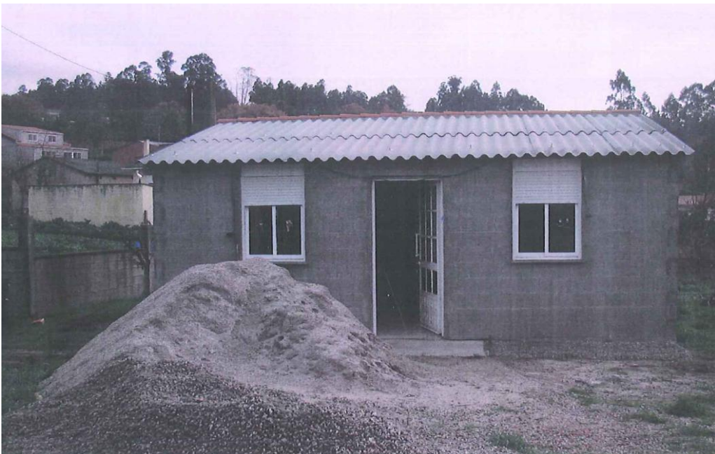
antes da demolición
