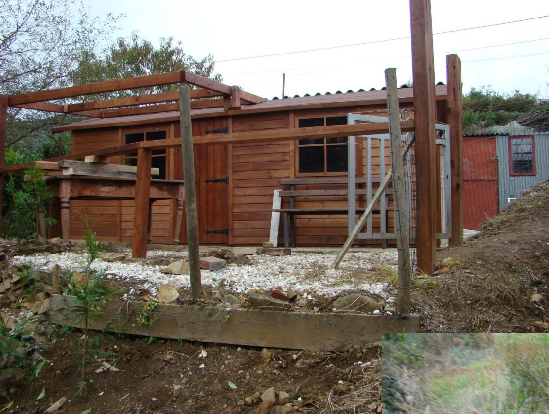
antes da demolición
