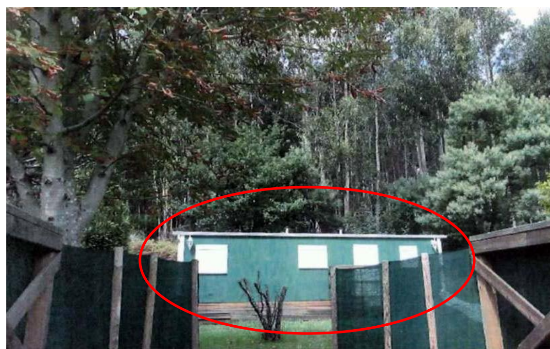
antes da demolición
