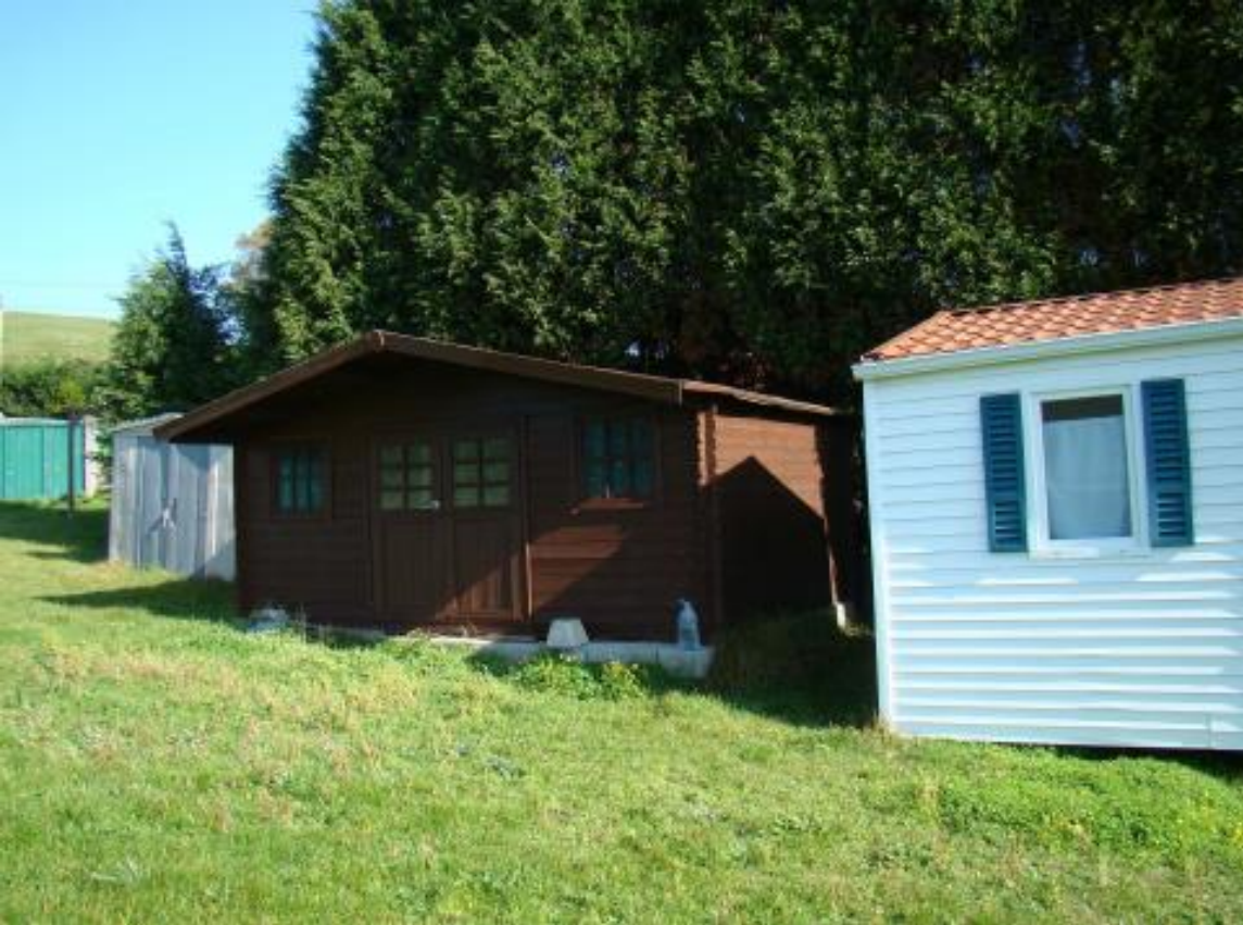
antes da demolición
