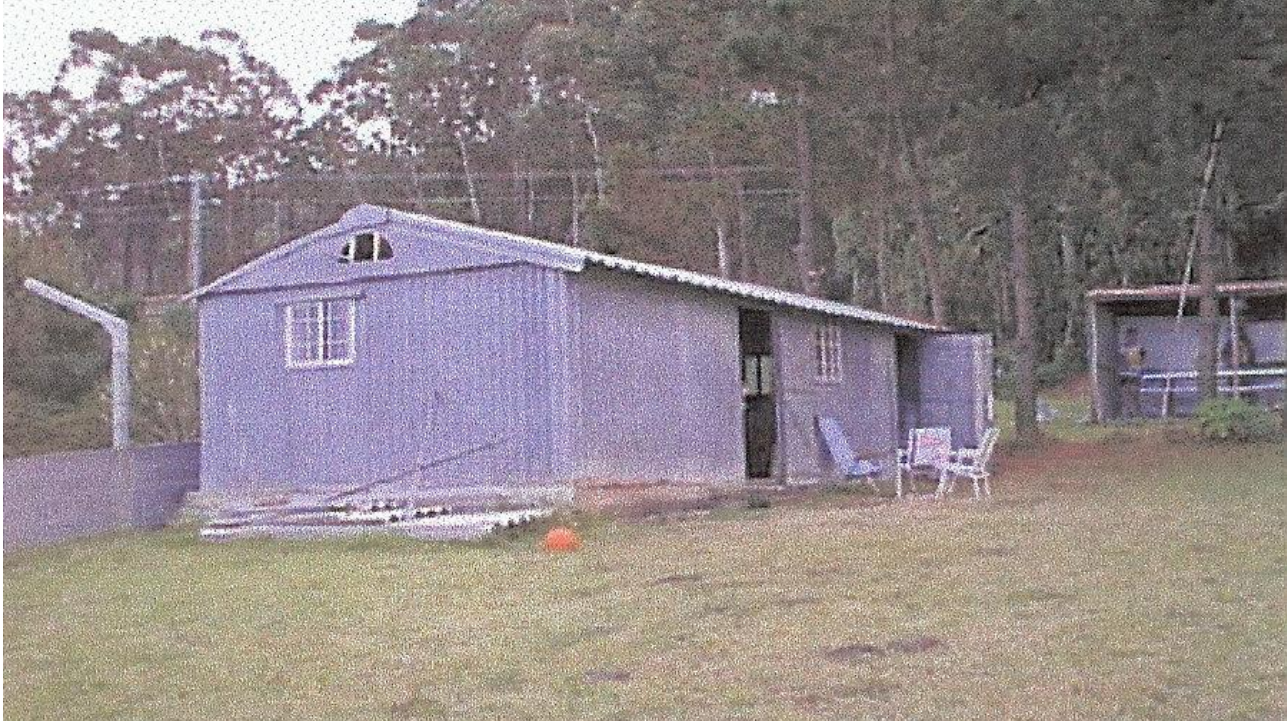
antes da demolição
