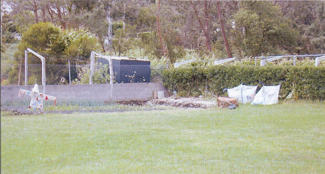
despois da demolição
