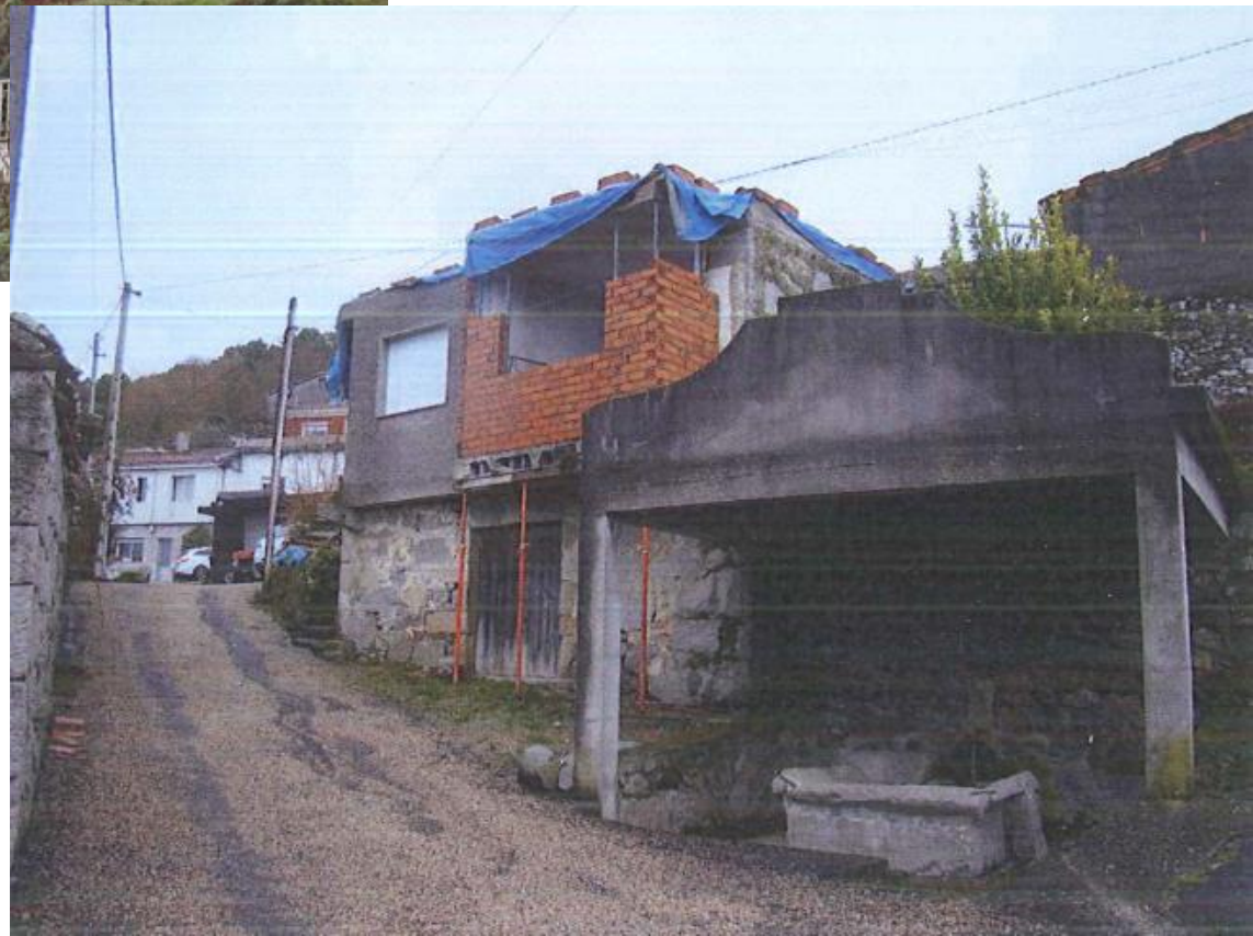
despois da demolición
