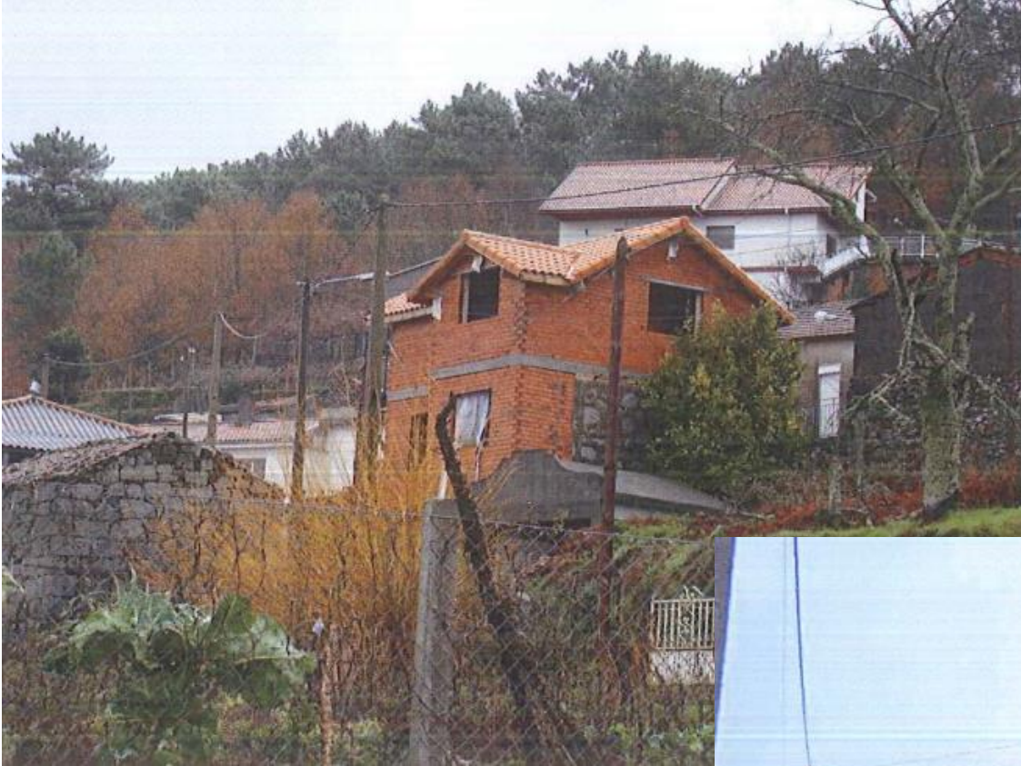
antes da demolición
