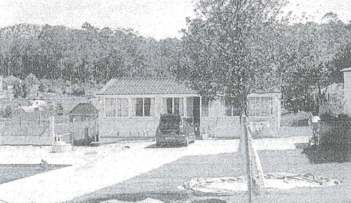
antes da demolición
