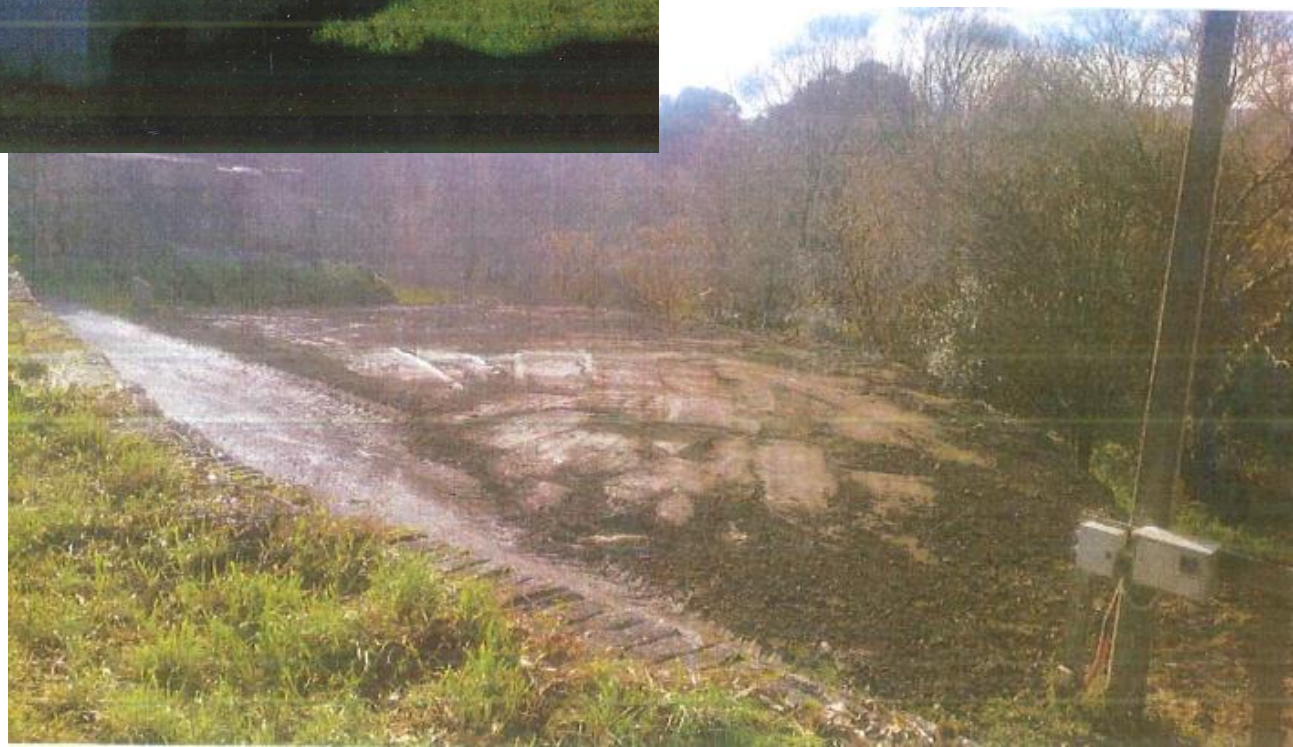
despois da demolición
