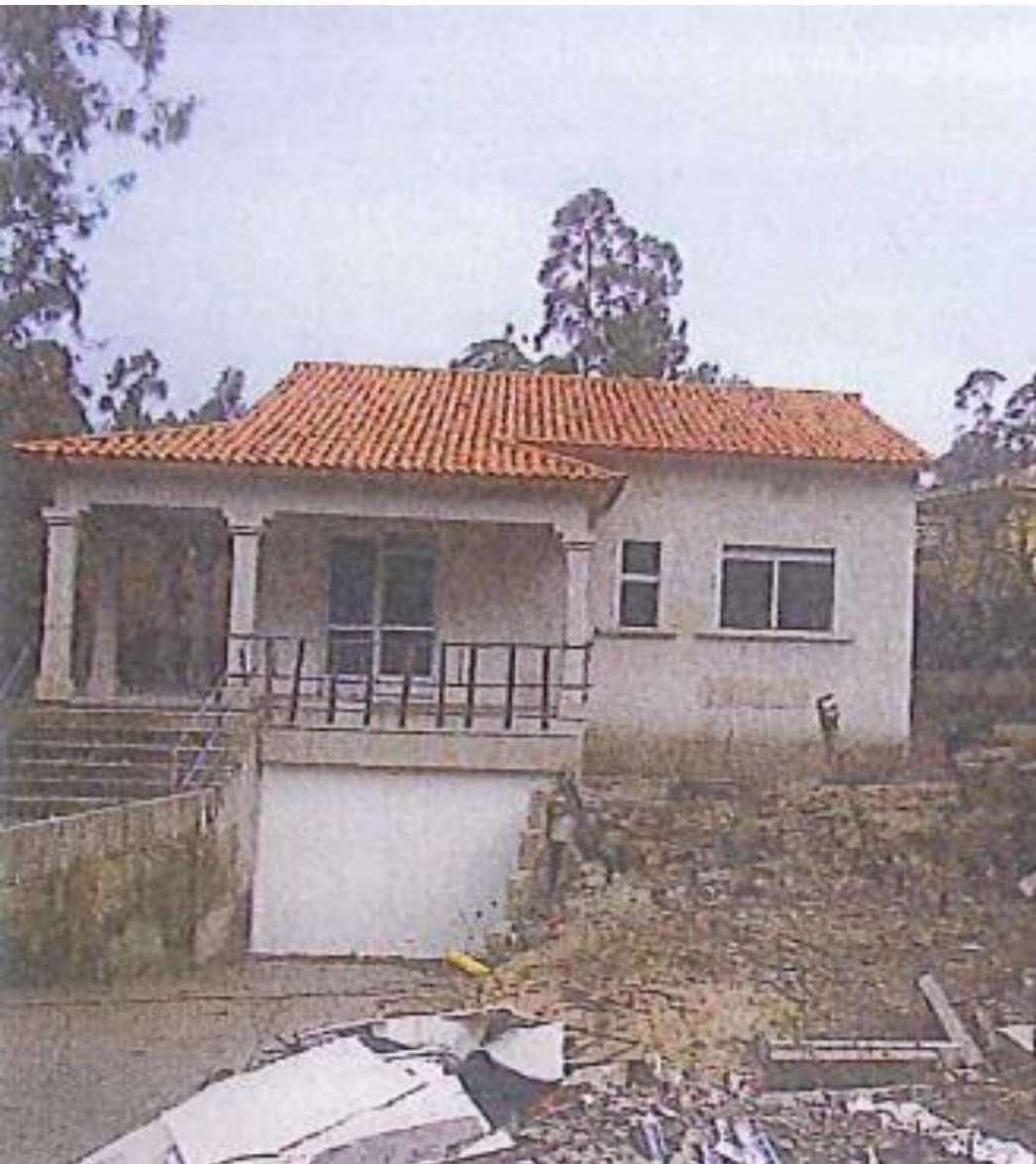
antes da demolición
