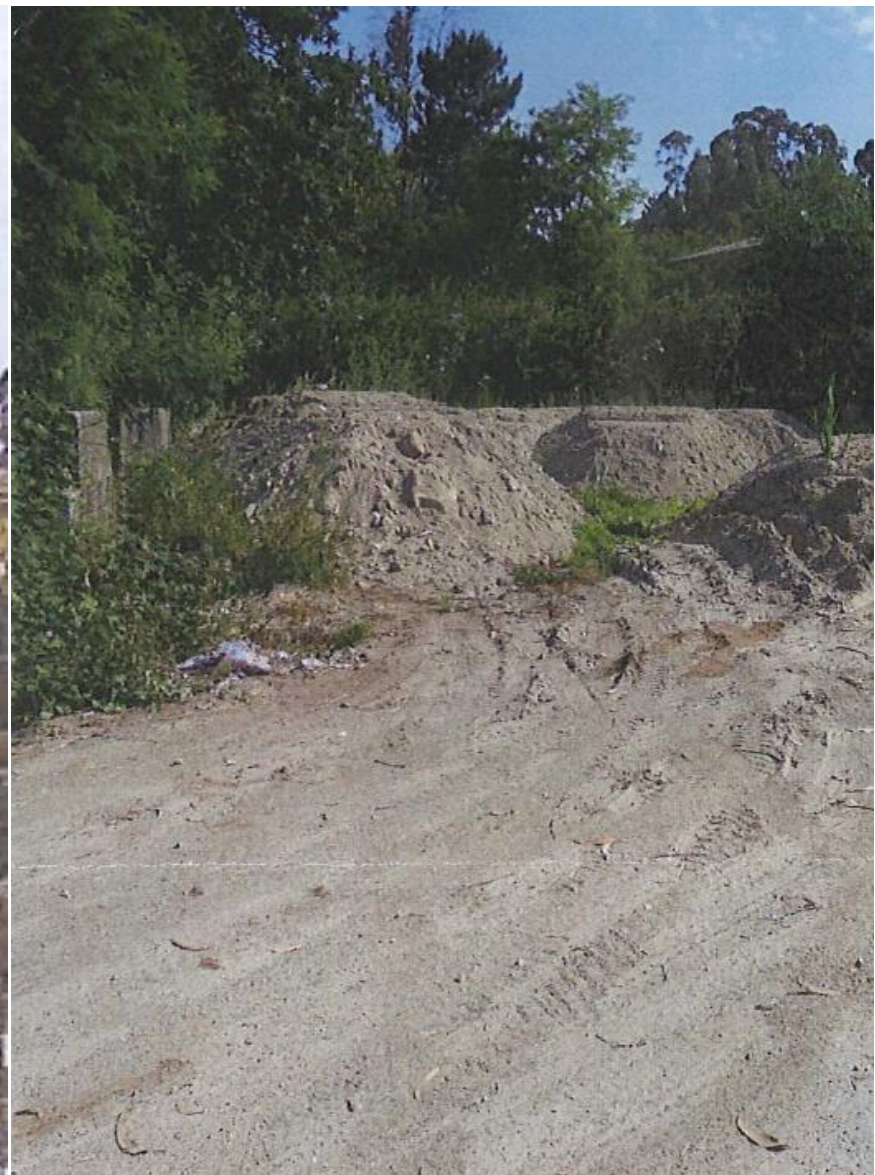
despois da demolición
