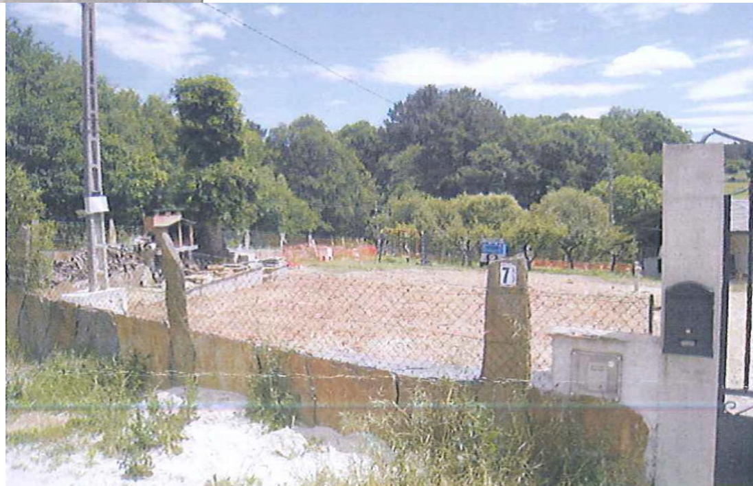
despois da demolición
