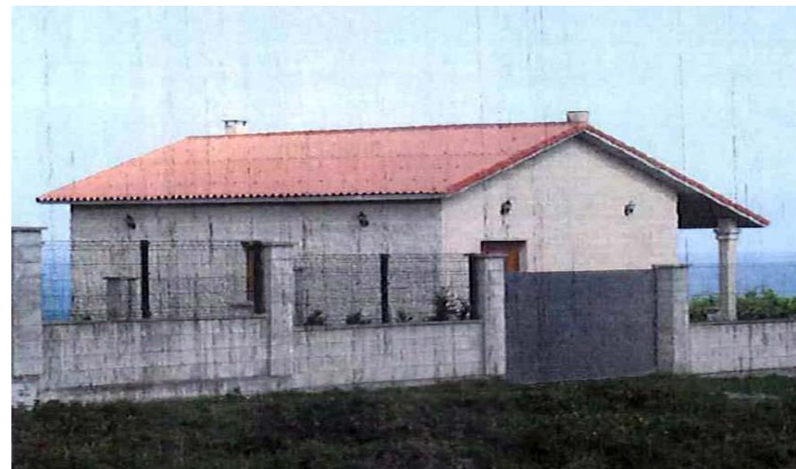
antes da demolición
