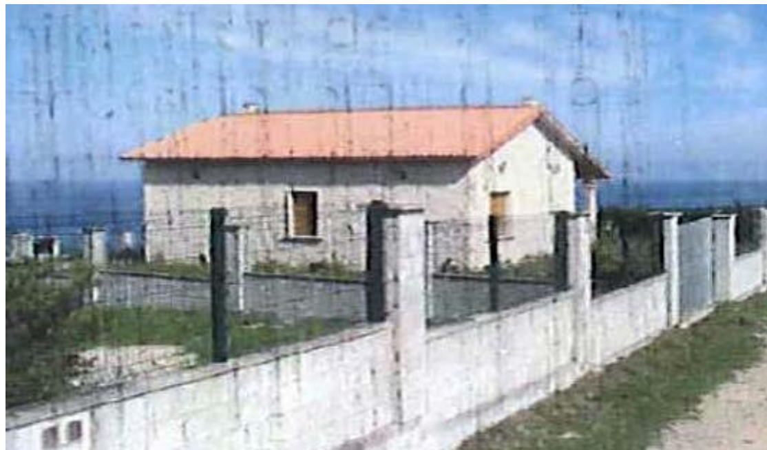
antes da demolición
